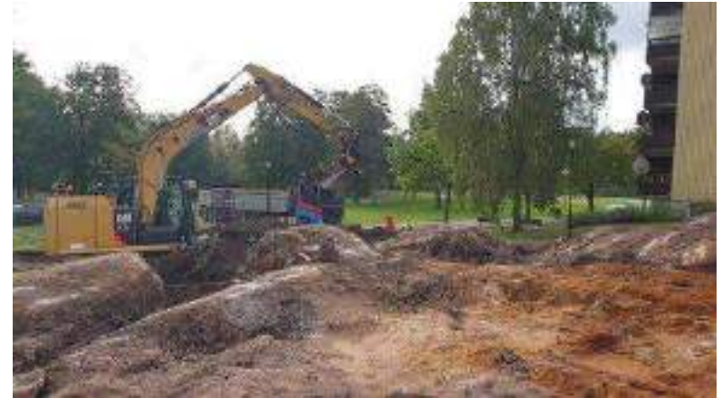
Excavación y disposición de suelos
