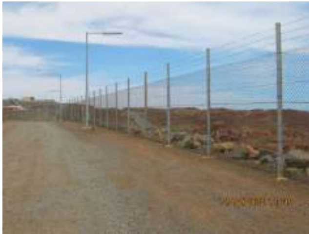
Cercado y señalización
